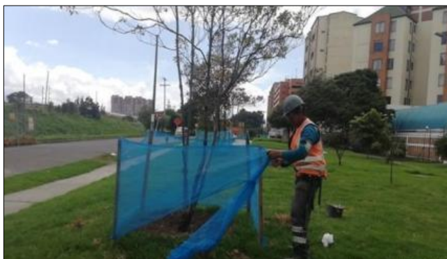
Protección de Arbolado. Fuente IDU
